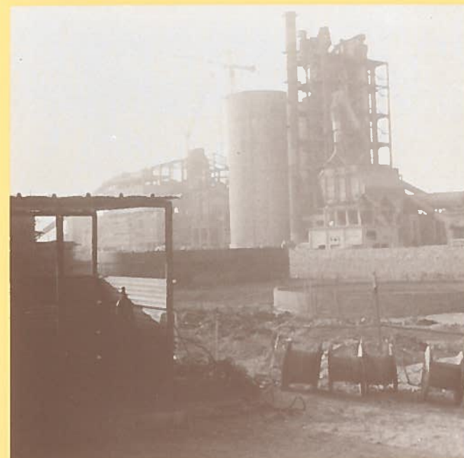
Egipt, Kairo (Tabin), 1983. Pri gradnji cementarne.
