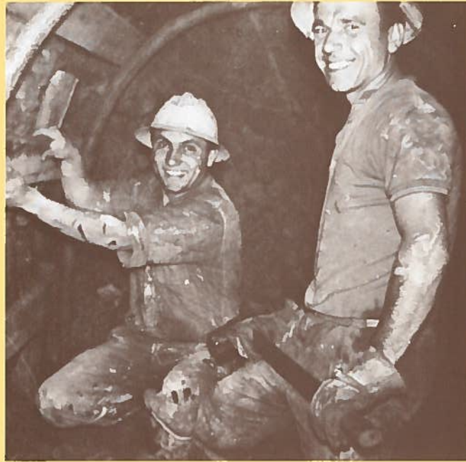
Avstralija, Melbourne, 1963. Delo pri vodovodnem omrežju. Avstralia, Melbourne 1963. Lavori all'acquedotto.
